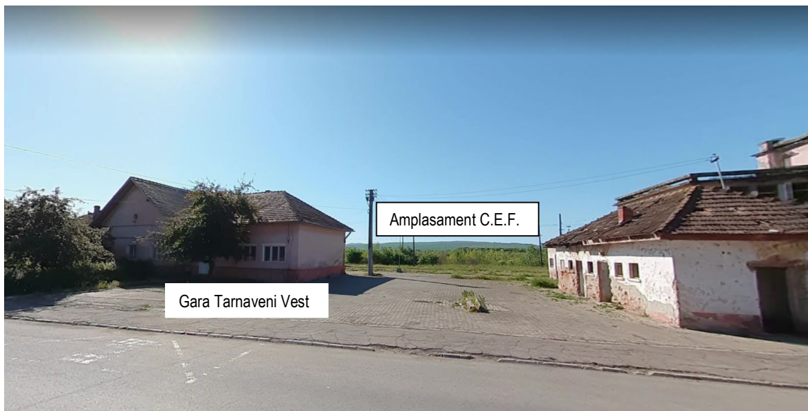
3. Vedere spre amplasament C.E.F
