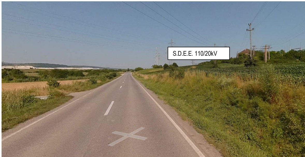
4. Vedere din DJ107D spre S.D.E.E. Tarnaveni 110/20kV (punct de conexiune C.E.F. la S.E.N.)
